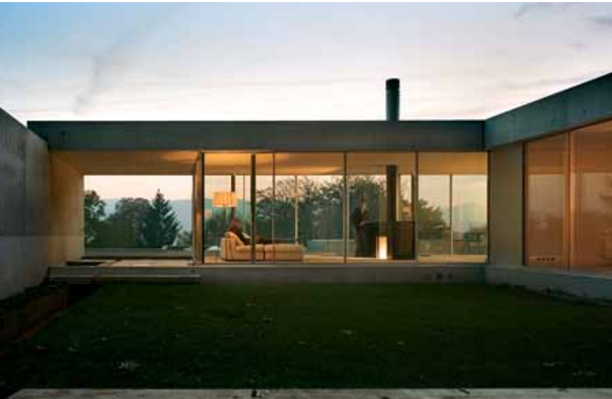
Fließendes Raumkontinuum mit Schiebefenster „Sky-Frame“ Stadterrasse, Winterthur 2005 Peter Kunz
