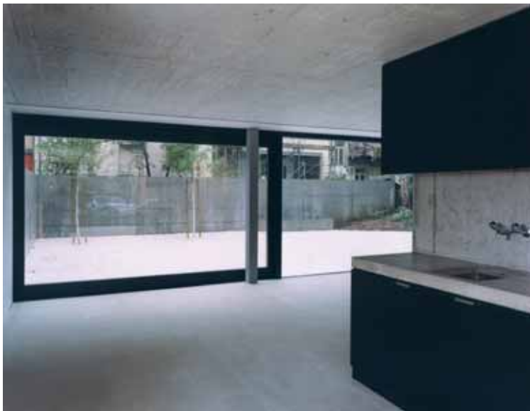
Schiebefenster mit übergroßem Flügelrahmen, Lofthaus, Basel 2000-2002 Buchner Bründler Architekten
