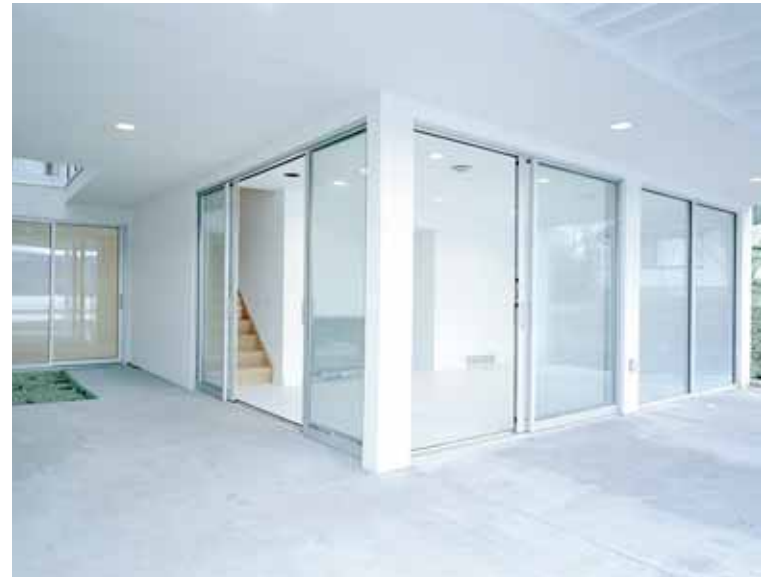
Amerikanisches Standard- schiebefenster, eingesetzt als Füllelement zwischen Stützen, Wand und Unterzug
